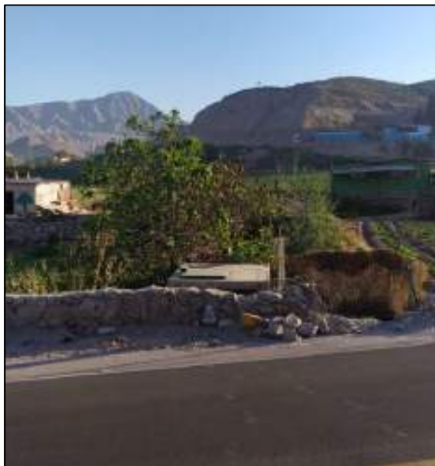
Figura 3.3.2.2- 7. Caseta de bombas
