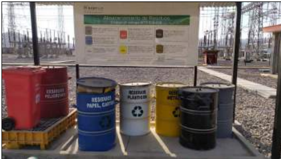
Figura 3.3.2.2- 5. Punto limpio (almacén de residuos)
