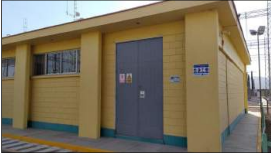
Figura 3.3.2.2- 4. Sala de control
