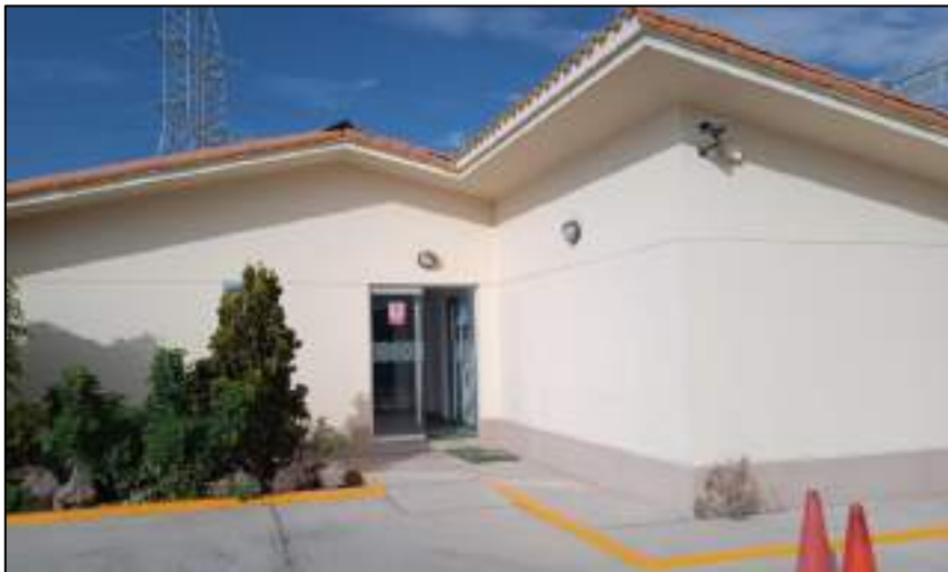
Figura 3.3.2.1- 5. Sala de control
